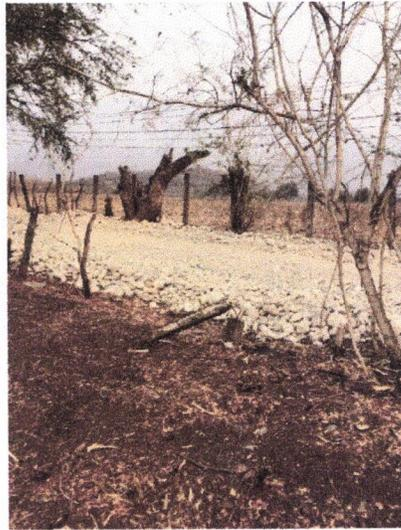
CONFORMACION Y EXTENDIDO DE MATERIAL DE REVESTIMIENTO, EN CAPAS DE HASTA 20 CM. COMPACTADO CON EQUIPO NEUMATICO, AGREGANDO AGUA NECESARIA, INCLUYE: MATERIALES, MANO DE OBRA, ACARREOS, EQUIPO Y HERRAMIENTA.
