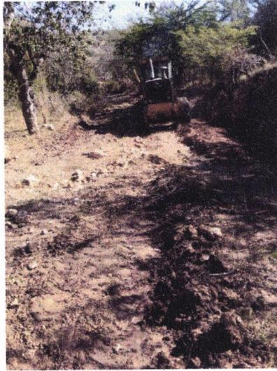
ESCARIFICADO CON MAQUINA EN MATERIAL TIPO II-"B", EN SECO, CON PROFUNDIDAD DE 0.00 A 1.00 MTS. INCLUYE: EQUIPO Y OPERACIÓN.
