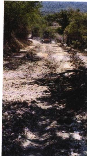
ESCARIFICADO CON MAQUINA EN MATERIAL TIPO II-"B", EN SECO, CON PROFUNDIDAD DE 0.00 A 1.00 MTS. INCLUYE: EQUIPO Y OPERACIÓN.
