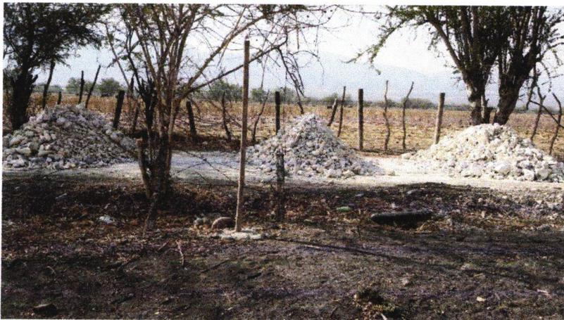
CONFORMACION Y EXTENDIDO DE MATERIAL DE REVESTIMIENTO, EN CAPAS DE HASTA 20 CM. COMPACTADO CON EQUIPO NEUMATICO, AGREGANDO AGUA NECESARIA, INCLUYE: MATERIALES, MANO DE OBRA, ACARREOS, EQUIPO Y HERRAMIENTA.
