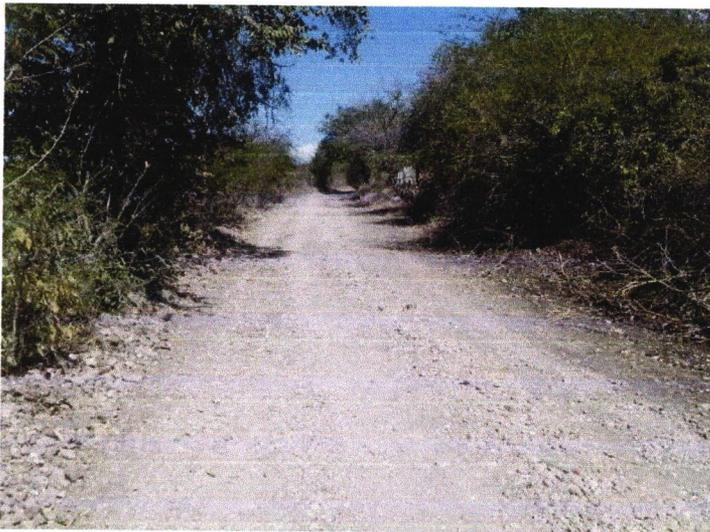
CONFORMACION Y EXTENDIDO DE MATERIAL DE REVESTIMIENTO, EN CAPAS DE HASTA 20 CM. COMPACTADO CON EQUIPO NEUMATICO, AGREGANDO AGUA NECESARIA, INCLUYE: MATERIALES, MANO DE OBRA, ACARREOS, EQUIPO Y HERRAMIENTA.
