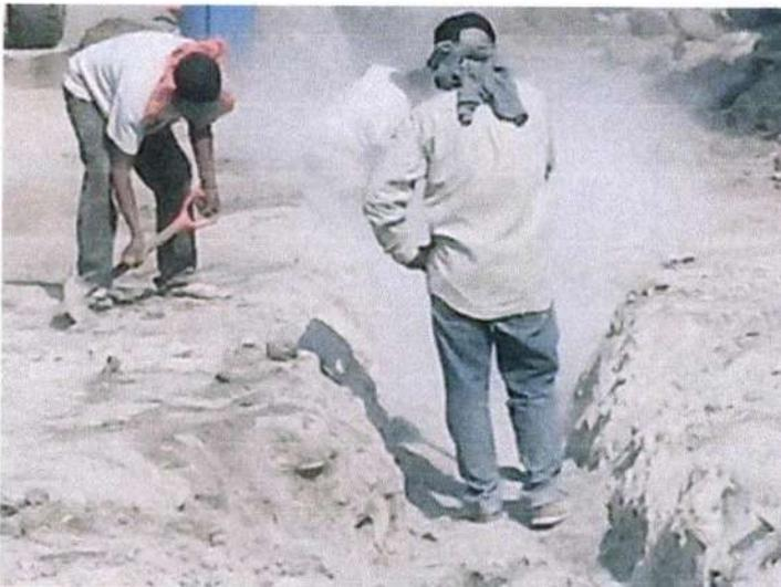
RELLENO Y COMPACTACION CON MATERIAL DE BANCO MEJORADO, EN CAPAS DE HASTA 20 CM. COMPACTADO CON EQUIPO NEUMATICO, AGREGANDO AGUA NECESARIA, INCLUYE: 20% DE ABUNDAMIENTO, MATERIALES, MANO DE OBRA, ACARREOS, EQUIPO Y HERRAMIENTA.
