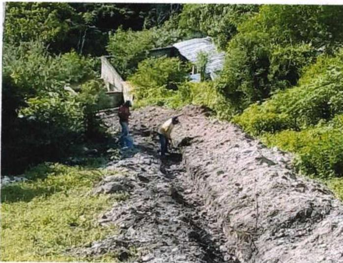
EXCAVACION DE ZANJAS, DE FORMA MANUAL EN MATERIAL TIPO II - "B", CON PRESENCIA DE BOLEO, EN SECO, CON PROFUNDIDAD DE 0.00 A 2.00 MTS, INCLUYE: MANO DE OBRA Y HERRAMIENTA.
