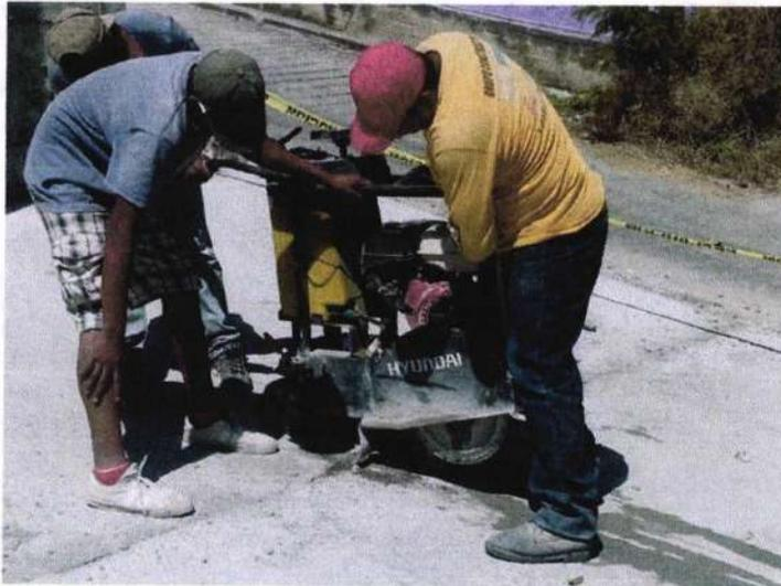
CORTE DE PAVIMENTO HIDRAULICO, CON CORTADORA DE DISCO DE DIAMANTE EN PAVIMENTO, INCLUYE: MATERIALES, MANO DE OBRA, EQUIPO Y TODO LO NECESARIO PARA SU CORRECTA EJECUCION.
