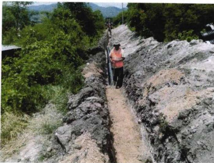
RELLENO Y COMPACTACION CON MATERIAL MEJORADO (CENICILLA), EN CAPAS DE HASTA 20 CM. COMPACTADO CON EQUIPO NEUMATICO, AGREGANDO AGUA NECESARIA, INCLUYE: 10% DE ABUNDAMIENTO, MATERIALES, MANO DE OBRA,
