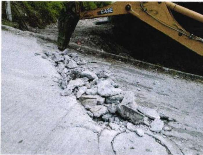
RUPTURA Y DEMOLICION DE CONCRETO SIMPLE DE 10-15 CM. ESPESOR, CON EQUIPO MECANICO, INCLUYE: EQUIPO, OPERACION Y TODO LO NECESARIO PARA SU CORRECTA EJECUCION. NO INCLUYE ACARREO.
