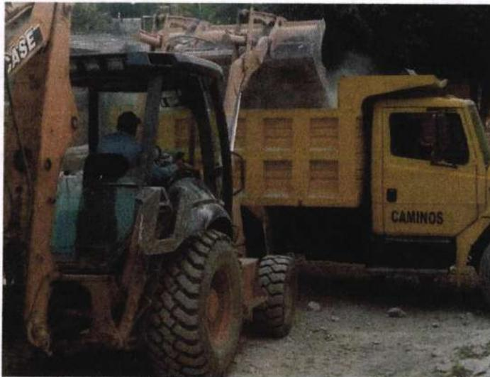
ACARREO DE ESCOMBROS PRODUCTO DE LA EXCAVACION Y/O DEMOLICION EN CAMION VOLTEO HASTA 1ER KM. FUERA DE LA OBRA, CARGADO CON MAQUINA, INCLUYE: EQUIPO Y OPERACION.
