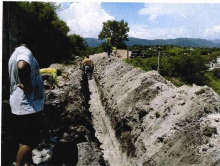
AFINE DE SUPERFICIE POR MEDIOS MANUALES, INCLUYE: RETIRO DE MATERIAL FUERA DE LA OBRA 1A ESTACION, MANO DE OBRA Y HERRAMIENTA.
