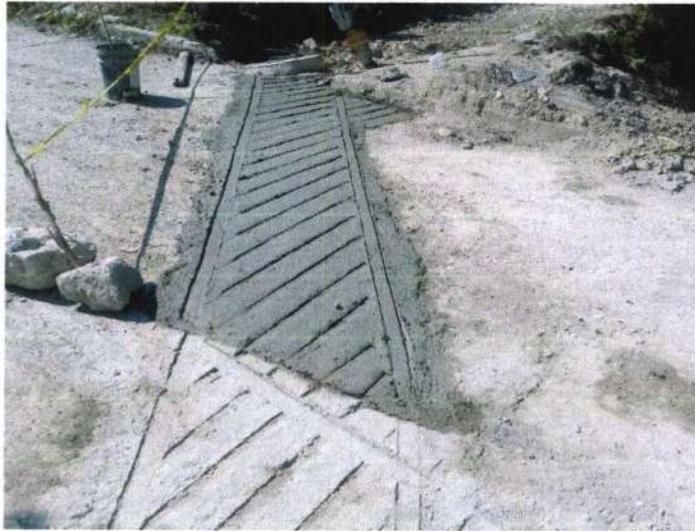
PAVIMENTACION CON CONCRETO HIDRAULICO DE F'C= 250 KG/CM2. DE 15 CM. DE ESPESOR, INCLUYE: REFUERZO CON MALLA ELECTROSOLDADA 6-6,10-10, CIMBRADO CENTRAL, COLADO Y DESCIMBRADO, MATERIALES, MANO DE OBRA, ACARREOS, EQUIPO Y HERRAMIENTA.
