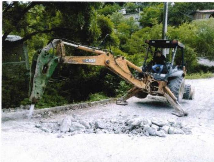
RUPTURA Y DEMOLICION DE CONCRETO SIMPLE DE 10-15 CM. ESPESOR, CON EQUIPO MECANICO, INCLUYE: EQUIPO, OPERACION Y TODO LO NECESARIO PARA SU CORRECTA EJECUCION. NO INCLUYE ACARREO.
