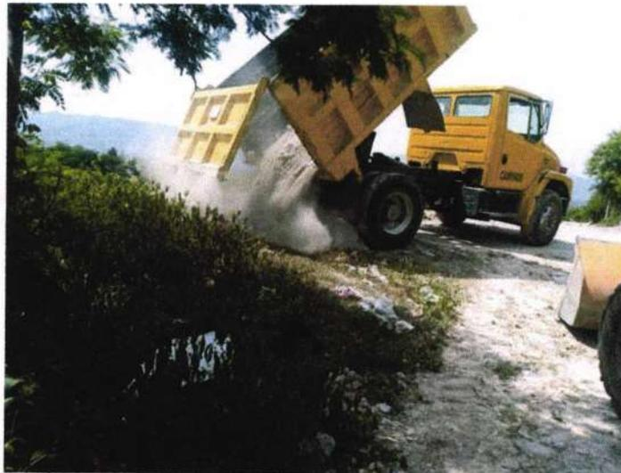
ACARREO DE ESCOMBROS PRODUCTO DE LA EXCAVACION Y/O DEMOLICION EN KILOMETRO SUBSECUENTE, INCLUYE: EQUIPO Y OPERACION.
