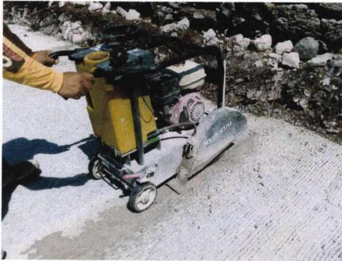
CORTE DE PAVIMENTO HIDRAULICO, CON CORTADORA DE DISCO DE DIAMANTE EN PAVIMENTO, INCLUYE: MATERIALES, MANO DE OBRA, EQUIPO Y TODO LO NECESARIO PARA SU CORRECTA EJECUCION..
