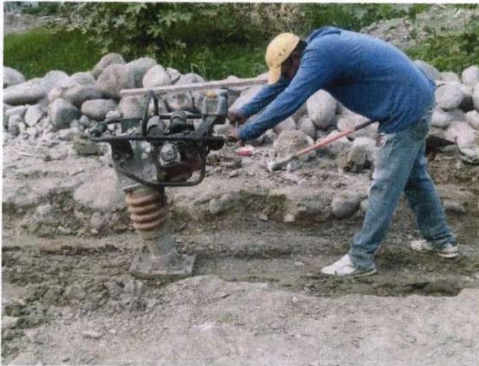
RELLENO Y COMPACTACION CON MATERIAL DE BANCO MEJORADO, EN CAPAS DE HASTA 20 CM. COMPACTADO CON EQUIPO NEUMATICO, AGREGANDO AGUA NECESARIA, INCLUYE: 20% DE ABUNDAMIENTO, MATERIALES, MANO DE OBRA, ACARREOS,
