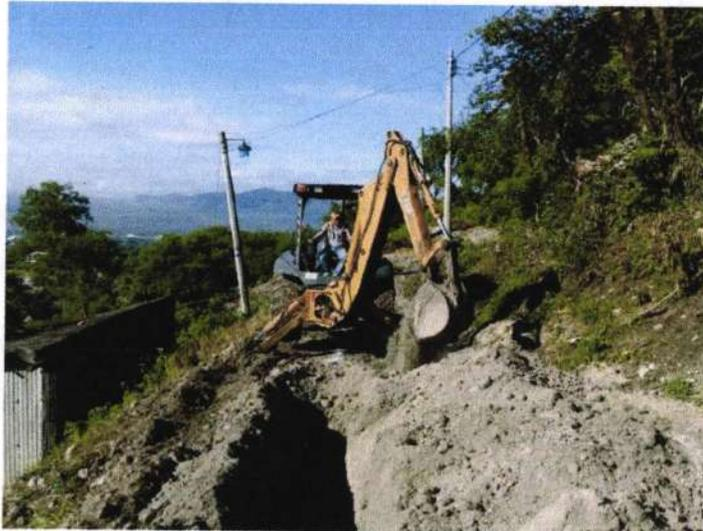
EXCAVACION CON MAQUINA EN MATERIAL TIPO II - "B", CON PRESENCIA DE BOLEO, EN SECO, CON PROFUNDIDAD DE 0.00 A 2.00 MTS, INCLUYE: EQUIPO Y OPERACION.
