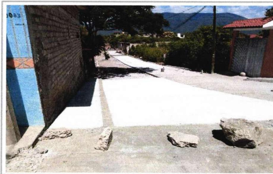
PAVIMENTACION CON CONCRETO HIDRAULICO PREMEZCLADO DE F`C= 250 KG/CM2. DE 15 CM. DE ESPESOR, TIRO LIBRE, INCLUYE: ADITIVOS, REFUERZO CON MALLA ELECTROSOLDADA 6-6,10-10, CIMBRADO CENTRAL, COLADO Y DESCIMBRADO, MATERIALES, MANO DE OBRA, ACARREOS, EQUIPO Y HERRAMIENTA.
