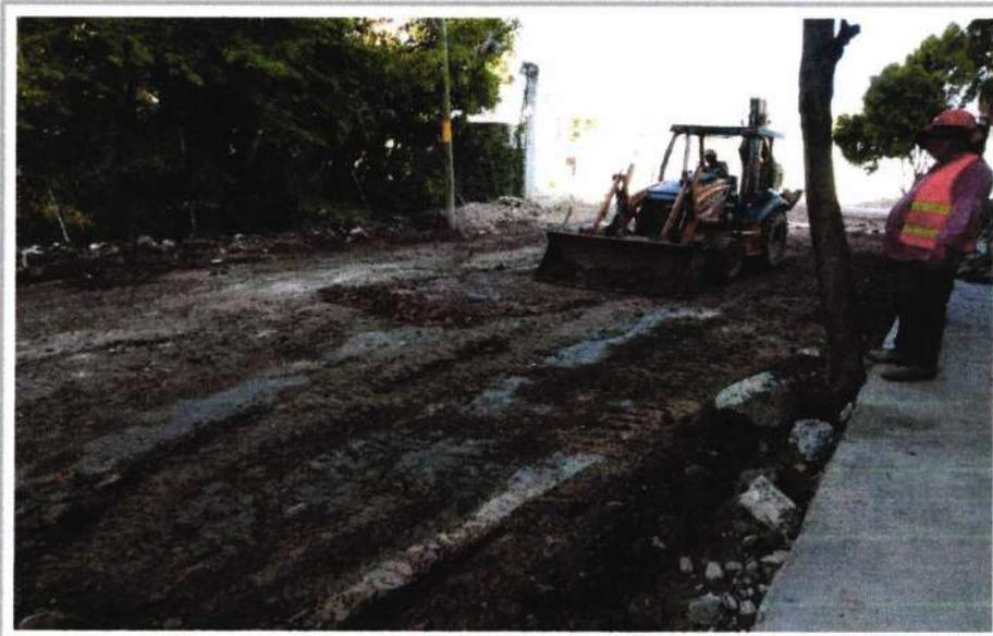
EXCAVACION CON MAQUINA EN MATERIAL TIPO II - "B", EN SECO, CON PROFUNDIDAD DE 0.00 A 2.00 MTS, INCLUYE: EQUIPO Y OPERACION.
