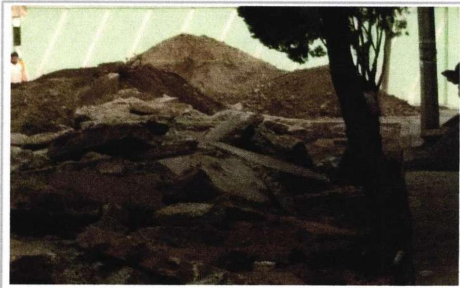
RUPTURA Y DEMOLICION DE CONCRETO SIMPLE DE 10-15 CM. ESPESOR, CON EQUIPO MECANICO, INCLUYE: EQUIPO, OPERACION Y TODO LO NECESARIO PARA SU CORRECTA EJECUCION. NO INCLUYE ACARREO.
