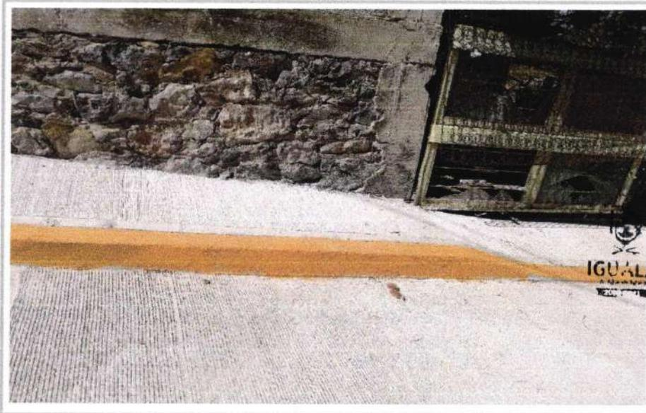
SUMINISTRO Y APLICACION DE PINTURA PARA TRAFICO CON MICROESFERA BASE SOLVENTE, EN GUARNICIONES Y LINEAS DE DEMARCAACION VIAL DE HASTA 0.30 M ANCHO, INCLUYE: LIMPIEZA, PREPARACIÓN DE LA SUPERFICIE, MATERIALES, MANO DE OBRA, HERRAMIENTA Y TODO LO NECESARIO PARA SU CORRECTA APLICACION.
