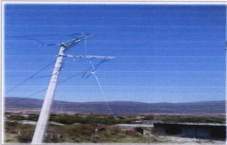
EQUIPAMIENTO DE POZO
