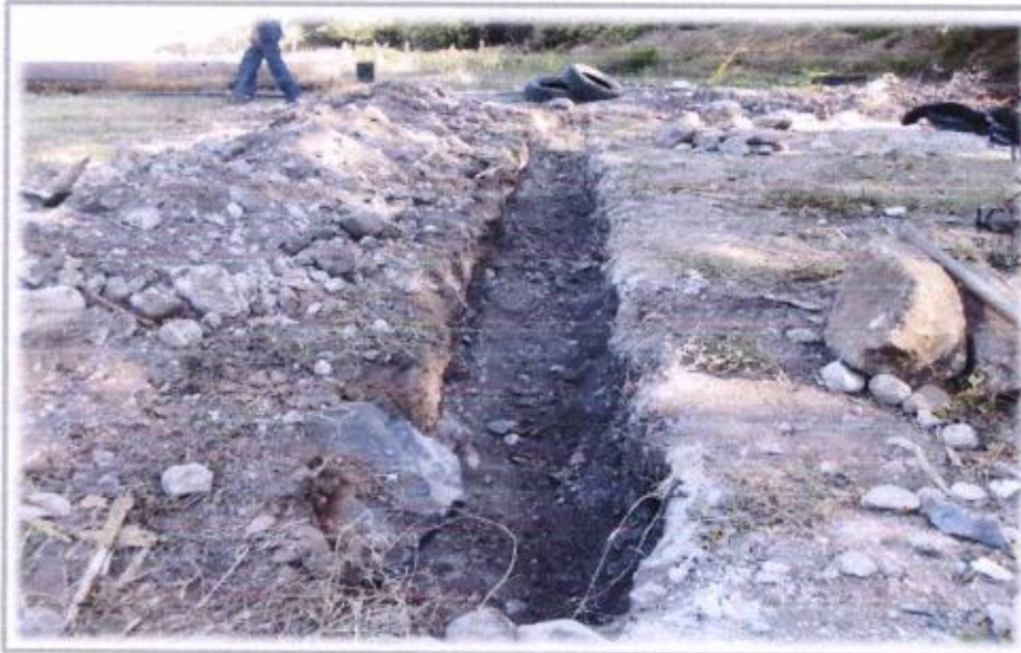
EQUIPAMIENTO DE POZO
