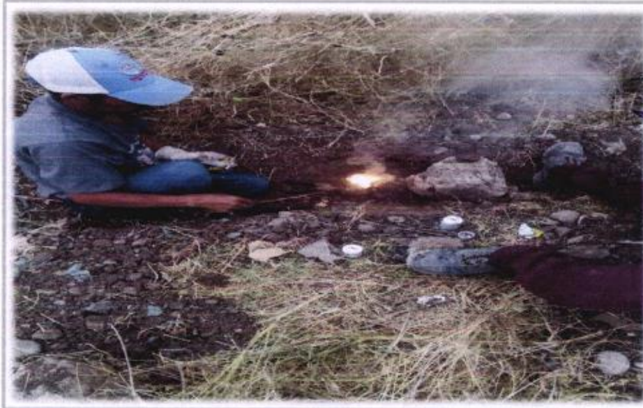
EQUIPAMIENTO DE POZO
