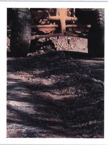
REVESTIMIENTO, EN CAPAS DE HASTA 20 CM. COMPACTADO **CON EQUIPO** NEUMATICO. AGREGANDO AGUA **NECESARIA, INCLUYE:** MATERIALES, MANO DE OBRA, ACARREOS. **EQUIPO Y**
