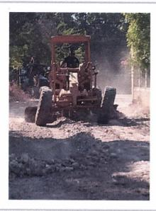
**CONFORMACION Y** EXTENDIDO DE MATERIAL DE REVESTIMIENTO, EN CAPAS DE HASTA 20 CM. COMPACTADO **CON EQUIPO** NEUMATICO. AGREGANDO AGUA NECESARIA, INCLUYE: MATERIALES, MANO DE OBRA, ACARREOS, **EQUIPO Y**
