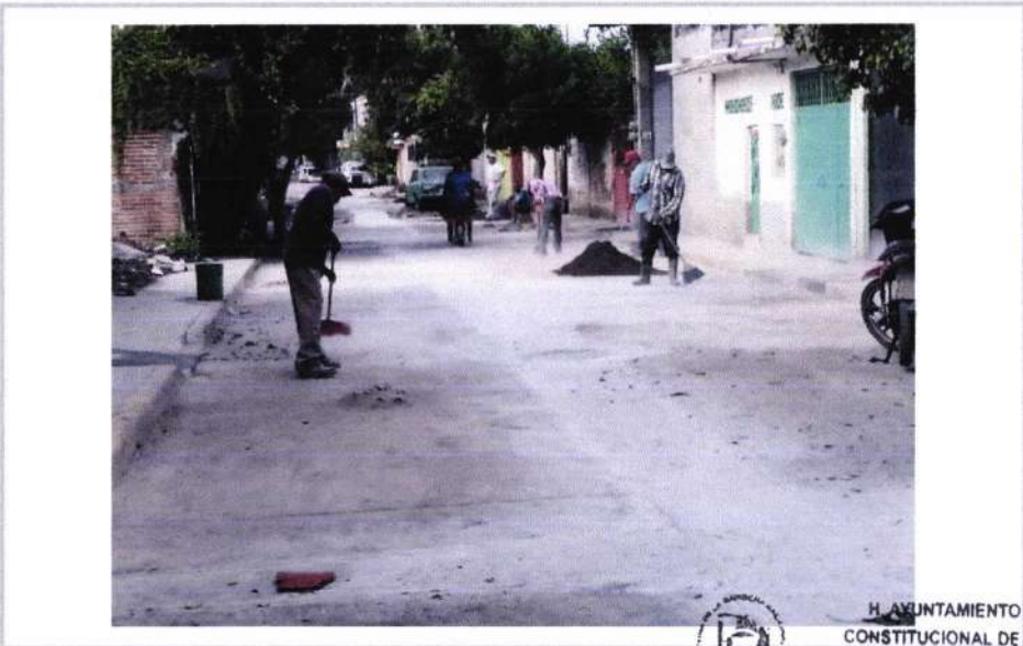
LIMPIEZA GENERAL MENOR DE LA OBRA P/ENTREGA, INCLUYE: MANO DE OBRA, EQUIPO Y HERRAMIENTA
