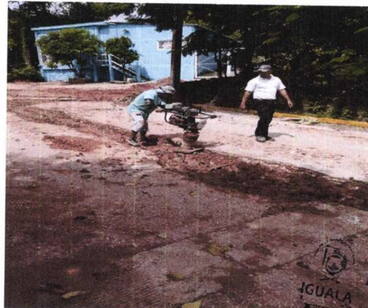
1131 06 RELLENO Y COMPACTACION CON MATERIAL DE BANCO MEJORADO, EN CAPAS DE HASTA 20 CM. COMPACTADO CON EQUIPO NEUMATICO, AGREGANDO AGUA NECESARIA, INCLUYE: MATERIALES, MANO DE OBRA, ACARREOS, EQUIPO Y HERRAMIENTA.
