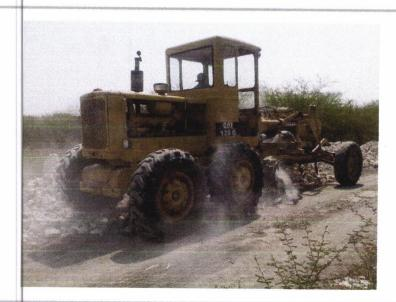
CONFORMACION Y EXTENDIDO DE MATERIAL DE REVESTIMIENTO, EN CAPAS DE HASTA 20 CM. COMPACTADO CON EQUIPO NEUMATICO. AGREGANDO AGUA NECESARIA, INCLUYE: MATERIALES, MANO DE OBRA, ACARREOS, **EQUIPO Y** HERRAMIENTA.
