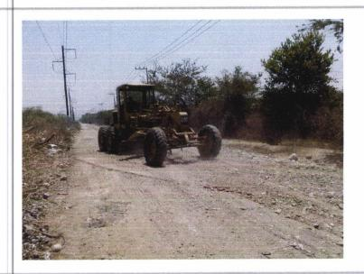
ESCARIFICADO CON MAQUINA EN MATERIAL TIPO II-"B", EN SECO, CON PROFUNDIDAD DE 0.00 A 1.00 MTS. INCLUYE: EQUIPO Y OPERACIÓN.
