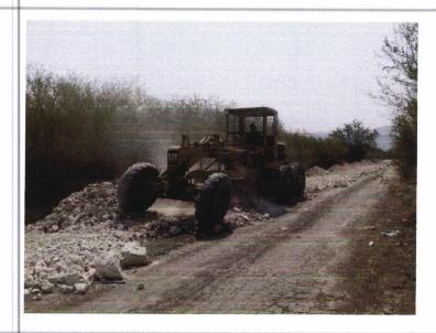
**CONFORMACION Y** EXTENDIDO DE MATERIAL DE REVESTIMIENTO, EN CAPAS DE HASTA 20 CM. COMPACTADO **CON EQUIPO** NEUMATICO. AGREGANDO AGUA NECESARIA, INCLUYE: MATERIALES, MANO DE OBRA, ACARREOS, **EQUIPO Y** MERRAMIENTA.
