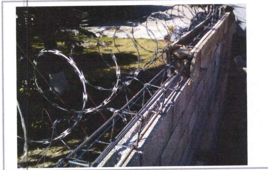
SUMINISTRO, COLOCACIÓN, HABILITADO Y ARMADO DE ACERO DE REFUERZO, EN ESTRUCTURA, FY= 4200 KG/CM , INCLUYE: ACARREOS TOTALES, FLETES DEL MATERIAL, DESPERDICIOS, TRASLAPES, SILLETAS, SEPARADORES, GANCHOS, MANO DE OBRA, EQUIPO Y LA HERRAMIENTA NECESARIA PARA LA
