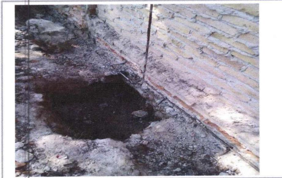
EXCAVACION DE ZANJAS, DE FORMA MANUAL EN MATERIAL TIPO II - "B", CON PRESENCIA DE BOLEO, EN SECO, CON PROFUNDIDAD DE 0.00 A 2.00 MTS, INCLUYE: MANO DE OBRA Y HERRAMIENTA.
