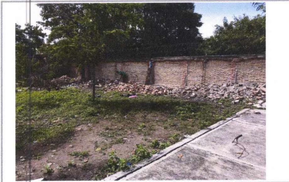
DEMOLICION A MANO DE MUROS DE TABIQUE O BLOCK DE 17 CM DE ESPESOR, INCLUYE: DALAS Y CASTILLOS HASTA 3.50 MTS. DE ALTURA, INCLUYE: ACARREO FUERA DE LA OBRA, MANO DE OBRA, EQUIPO Y HERRAMIENTA.
