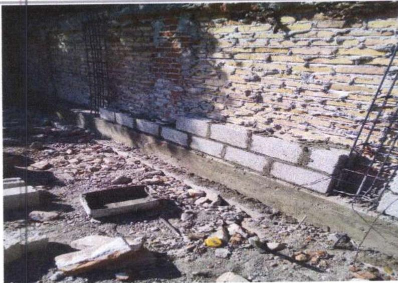
MUROS DE BLOCK PESADO DE 14 CM, HASTA 6.0 M. DE ALTURA, ACABADO APARENTE, JUNTEADO CON MORTERO CEMENTO-ARENA 1:5, INCLUYE: MATERIALES, MANO DE OBRA, EQUIPO Y HERRAMIENTA.
