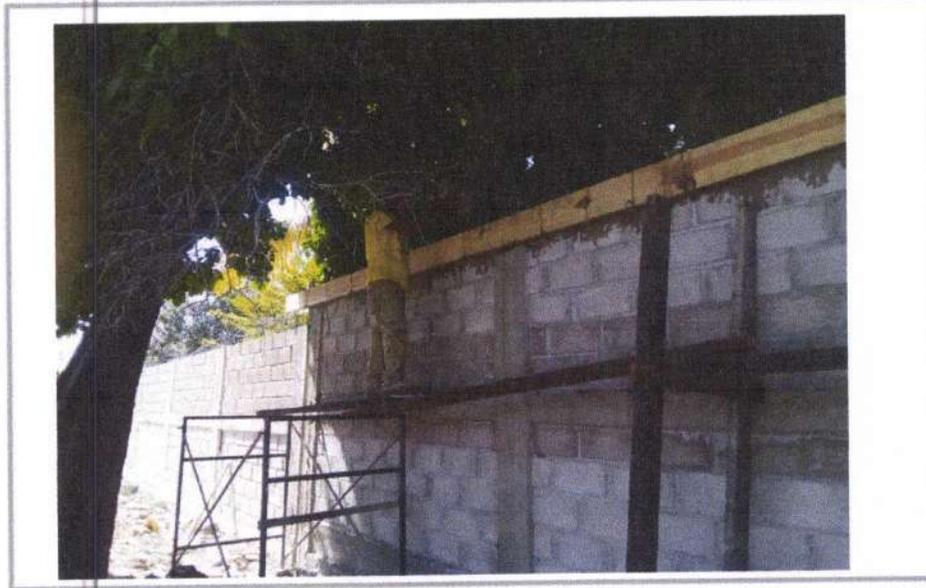
SUMINISTRO Y COLOCACION DE CIMBRA DE MADERA PARA ACABADOS APARENTES EN ESTRUCTURA. INCLUYE: MANO DE OBRA, EQUIPO, HERRAMIENTA, CORTES, SUMINISTRO DE LOS MATERIALES, ACARREOS DE LOS MATERIALES PUESTOS EN EL SITIO DE LOS TRABAJOS Y TODO LO NECESARIO PARA SU CORRECTA EJECUCION.
