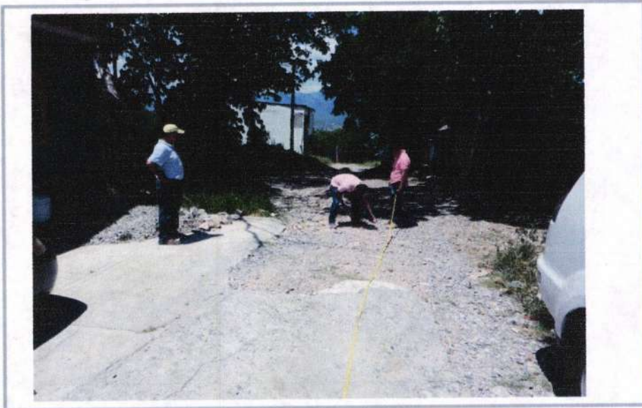
LIMPIEZA Y TRAZO EN EL AREA DE TRABAJO.
