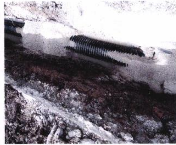
CAMA DE ARENA PARA ASENTAR TUBERIAS. COMPACTADO DE FORMA MANUAL. INCLUYE: SUMINISTRO Y COLOCACION, MANO DE OBRA, EQUIPO Y HERRAMIENTA
