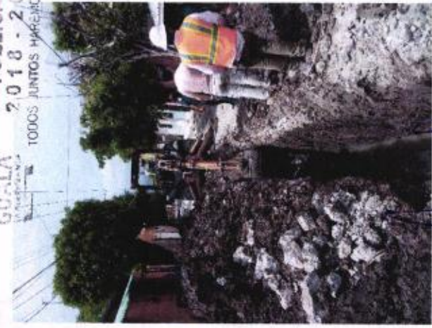
EXCAVACION CON MACUINA EN MATERIAL TIPO II - "B", EN SECO, CON PROFUNDIDAD DE 0.00 A 2.00 MTS. INCLUYE: EQUIPO Y OPERACION.
