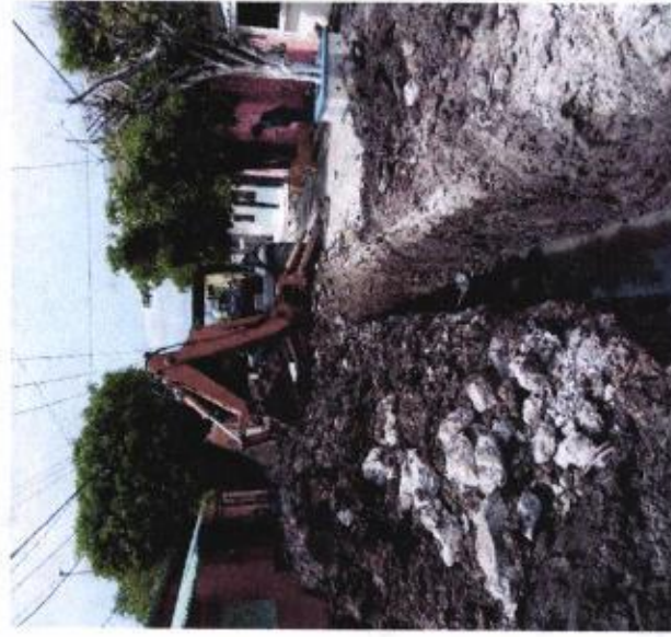
EXCAVACION CON MACUINA EN MATERIAL TIPO II - "B", EN SECO, CON PROFUNDIDAD DE 0.00 A 2.00 MTS. INCLUYE: EQUIPO Y OPERACION.
