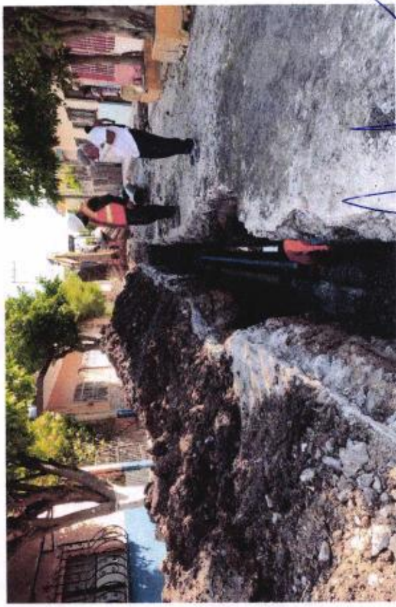
AFINE DE SUPERFICIE POR MEDIOS MANUALES, INCLUYE: RETIRO DE MATERIAL FUERA DE LA OBRA 1A ESTACION, MANO DE OBRA Y HERRAMIENTA.
