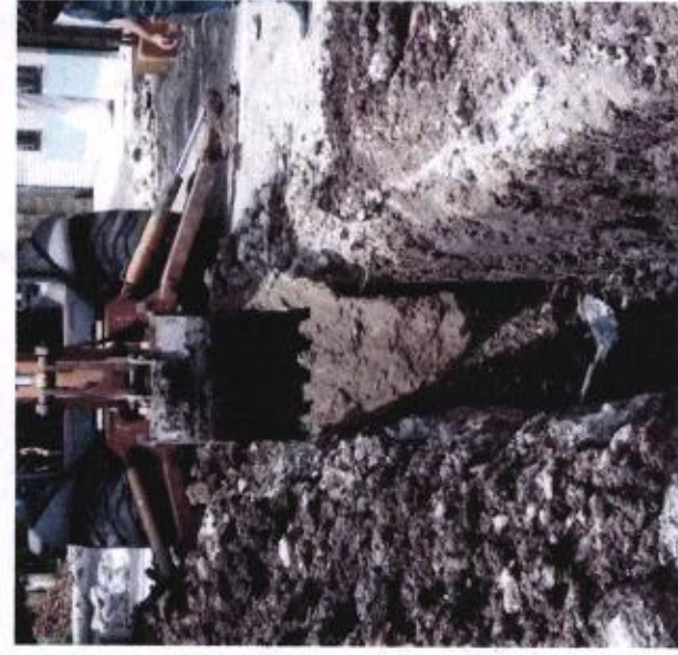
EXCAVACION CON MACUINA EN MATERIAL TIPO II - "B", EN SECO, CON PROFUNDIDAD DE 0.00 A 2.00 MTS. INCLUYE: EQUIPO Y OPERACION.
