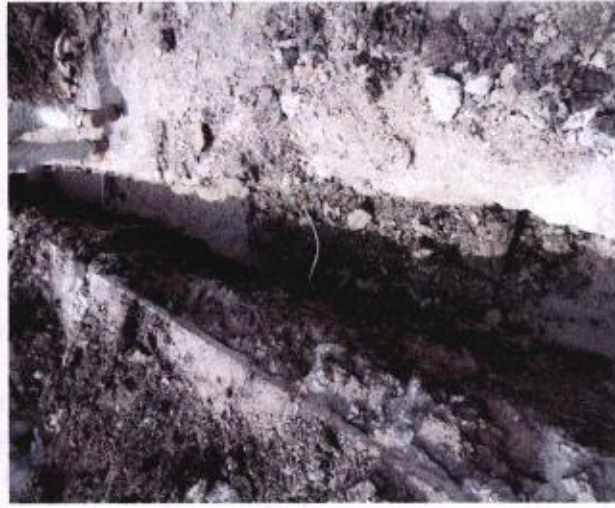
CAMA DE ARENA PARA ASENTAR TUBERIAS. COMPACTADO DE FORMA MANUAL. INCLUYE: SUMINISTRO Y COLOCACION, MANO DE OBRA, EQUIPO Y HERRAMIENTA
