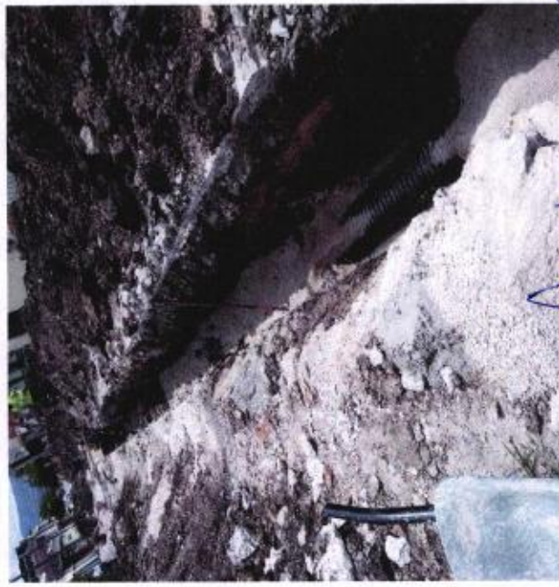
CAMA DE ARENA PARA ASENTAR TUBERIAS. COMPACTADO DE FORMA MANUAL. INCLUYE: SUMINISTRO Y COLOCACION, MANO DE OBRA, EQUIPO Y HERRAMIENTA
