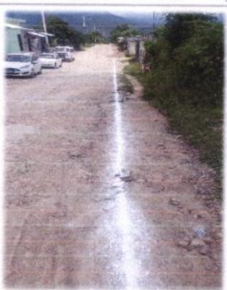
LIMPIEZA Y TRAZO EN EL AREA DE TRABAJO.
