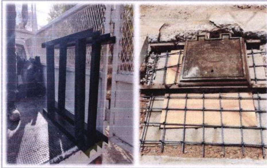
CONSTRUCCION DE LINEA DE CONDUCCION Y LINEA DE DISTRIBUCION
