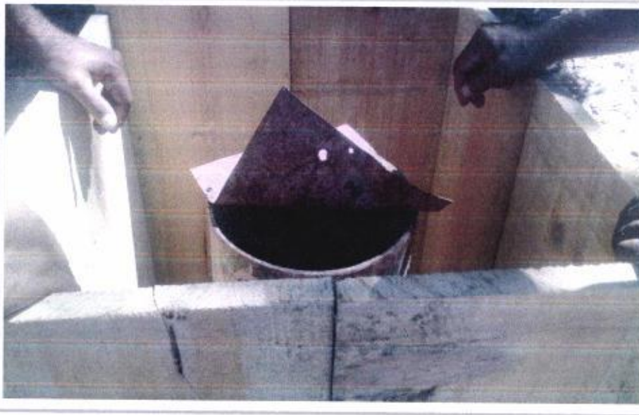
SUMINISTRO Y COLOCACION DE SELLO CEMENTADO
