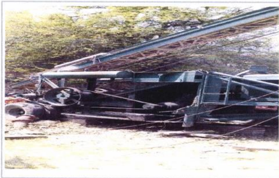
DESINSTALACION DE EQUIPO DE BOMBEO DAÑADO A UNA PROFUNDIDAD DE 120 M.
